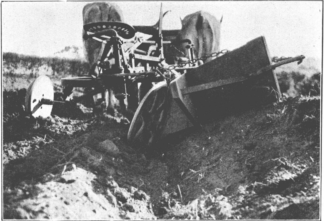
Fig. 17 --- Vista de trás do primeiro modelo construindo um camalhão de base estreita e talude abrupto. (Foto do autor.)
