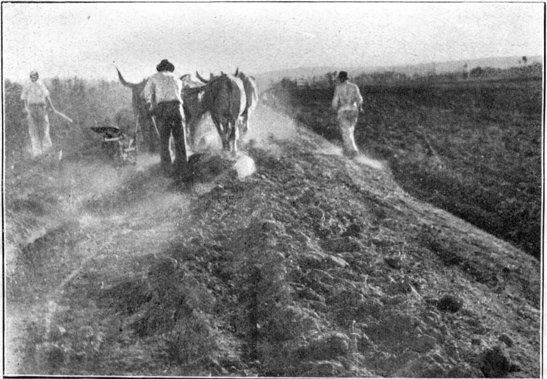
Fig. 22 — Vista posterior do conjunto em funcionamento ao dar a 10. a passada para a construção de um terraço de base larga. Foto do autor.)
