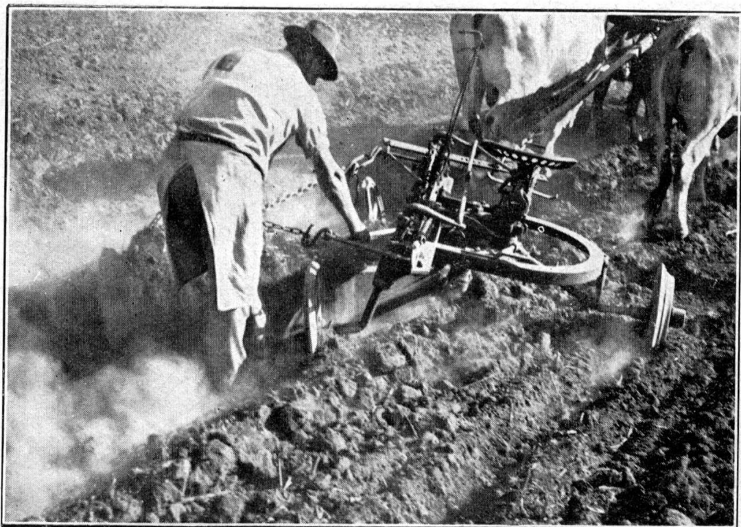
Fig. 19 — Vista posterior do conjunto em funcionamento ao dar a 1. a passada para a construção de um dique para irrigação. (Foto do autor.)
